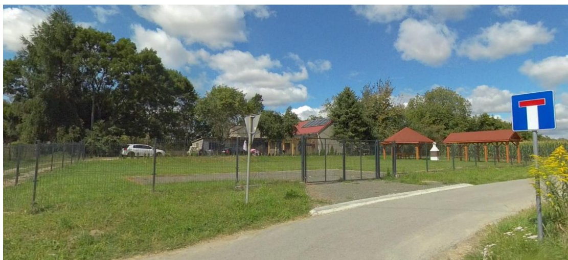
Zdjęcie 5 wykonaniem ogrodzenia przy świetlicy w Krasieńcu Zakupnym
