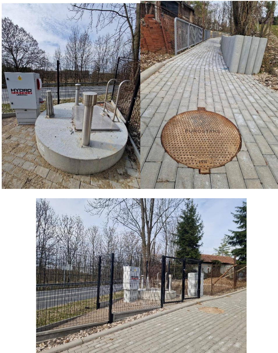
Zdjęcie 23 Budowa kanalizacji sanitarnej na ul. Jesionowej w miejscowości Iwanowice Dworskie
