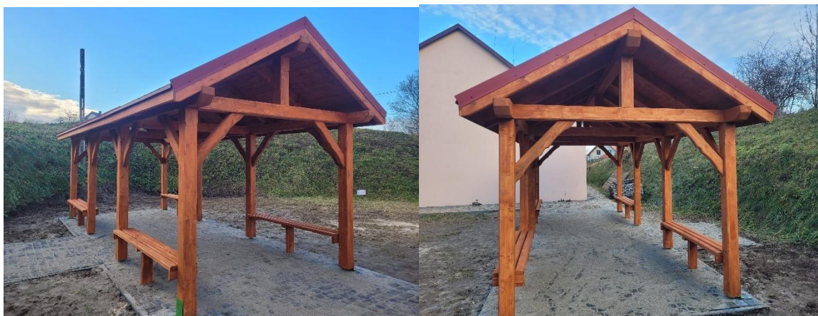
Zdjęcie 33 Budowa placu zabaw w miejscowości Damice
