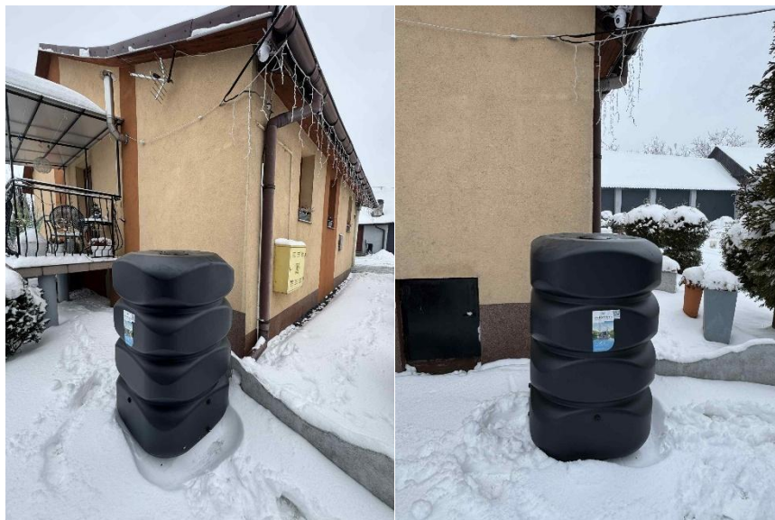
Zdjęcie 29 Zbiorniki na deszczówkę
