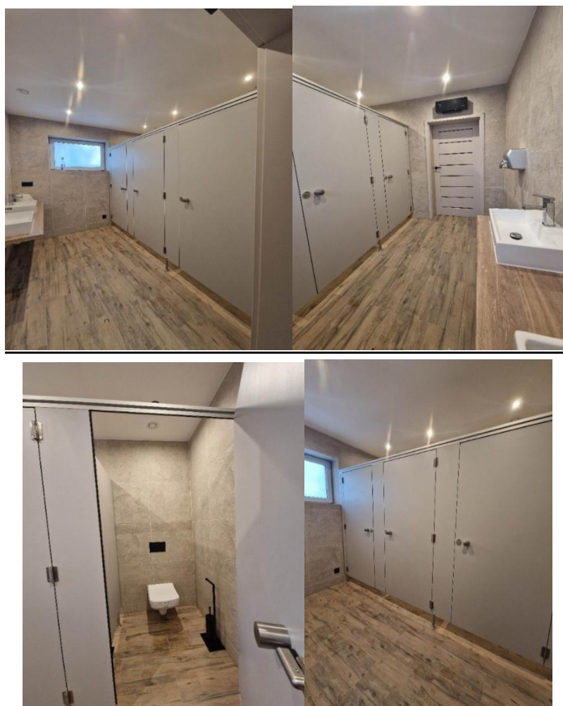
Zdjęcie 15 Remont łazienek w budynku remizy OSP Maszków
