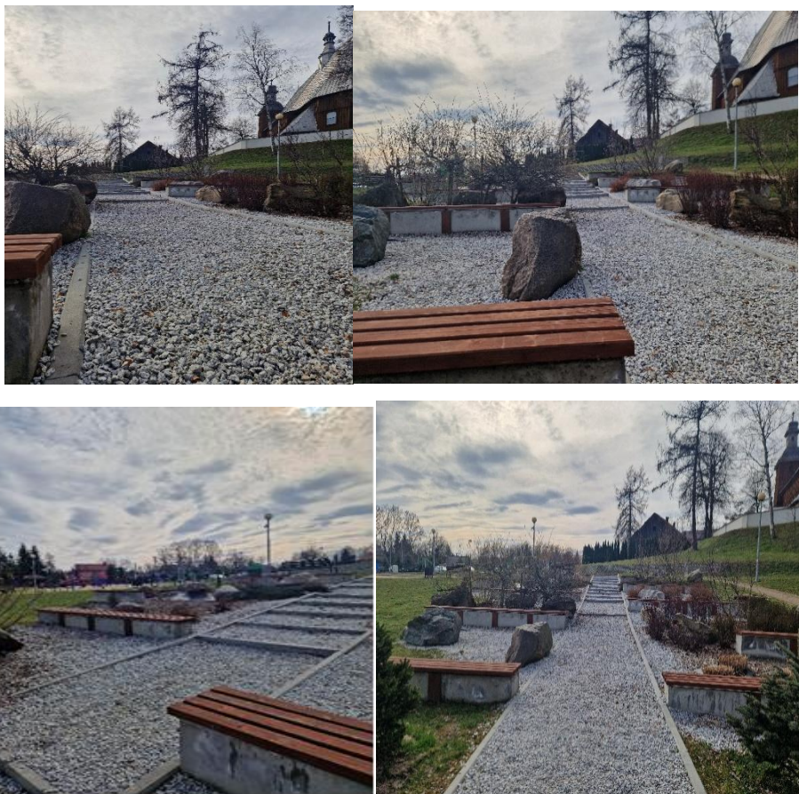
Zdjęcie 4 Remont arboretum na Nowoczesnym Zapleczu Sportowo Rekreacyjnym w Iwanowicach
