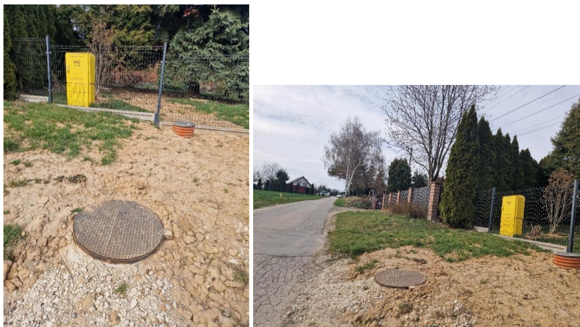
Zdjęcie 22 Budowa kanalizacji sanitarnej w miejscowości Krasieniec Zakupny „ul. Zielna
