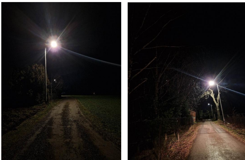
Zdjęcie 28 Rozbudowie oświetlenia ulicznego w miejscowości Władysław
