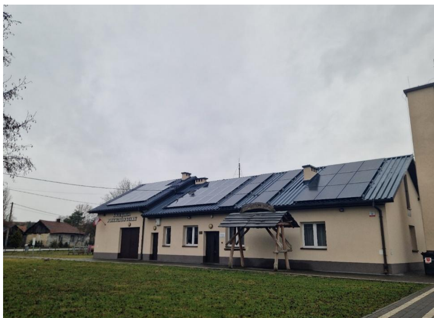
Zdjęcie 30 Wykonanie instalacji fotowoltaicznej w świetlicy w Poskwitowie
