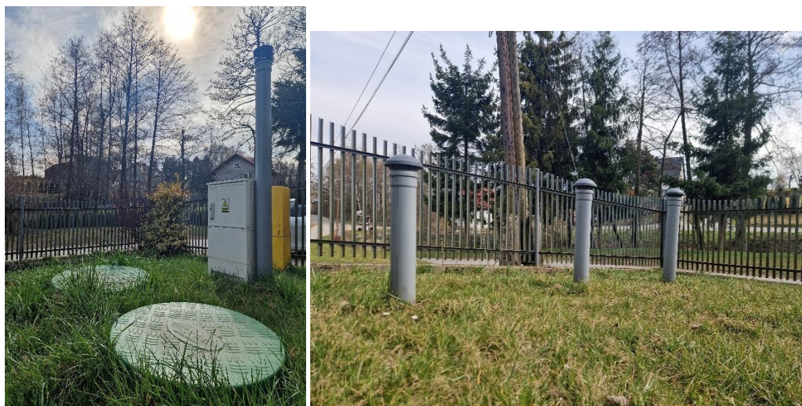
Zdjęcie 24 Budowę przydomowych oczyszczalni ścieków
