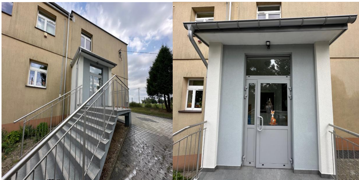
Zdjęcie 10 Zmodernizowane wejście do szkoły w Celinach
