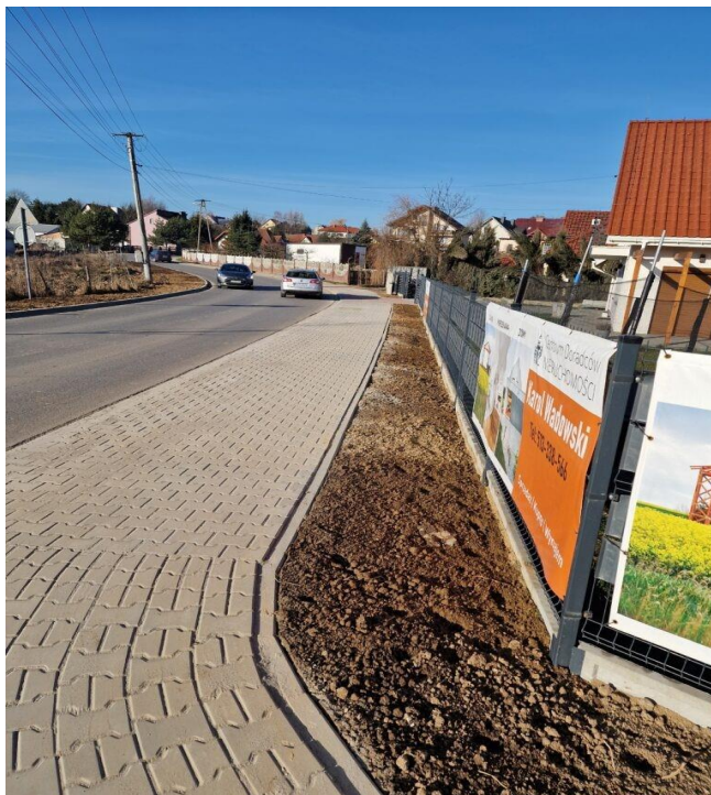
Zdjęcie nr 5. „Modernizację nawierzchni drogi gminnej w miejscowości Narama ul. Brzozowa
